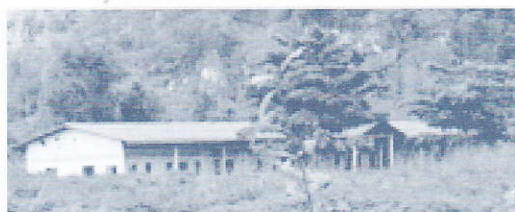
屋根と壁の一部の修理が終わった小学校
