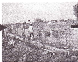
レンガを積み上げ、セメントをぬります。
