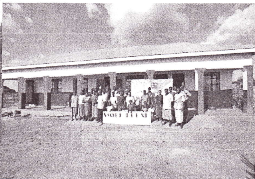
写真下: 完成した「スマイル・ハウス」(ウガンダ・グル)
