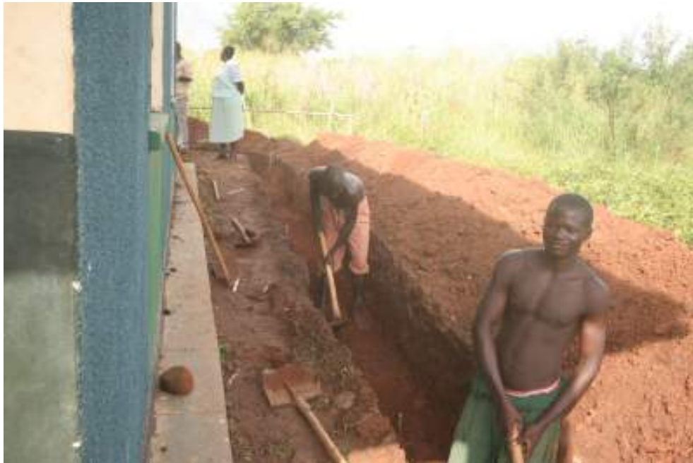
(写真上)基礎工事の様子。2000平方メートルの敷地に深さ1m弱の穴を掘りそこにセメントを流し、そこにレンガを積み上げていく作業です。
