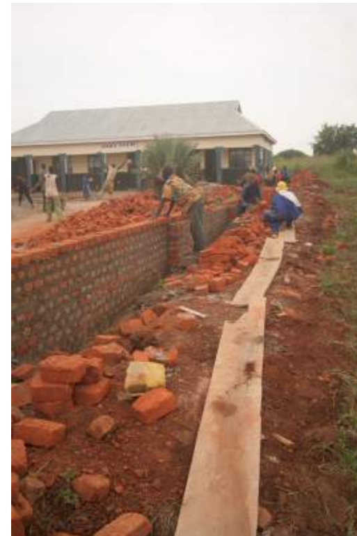
(写真上)基礎工事の様子。2000平方メートルの敷地に深さ1m弱の穴を掘りそこにセメントを流し、そこにレンガを積み上げていく作業です。
