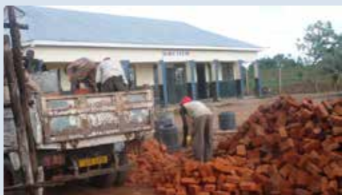
建設中のスマイルハウス
