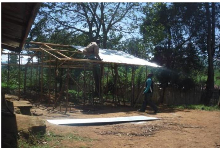
施設の骨組みが完成し、屋根を設置している様子
