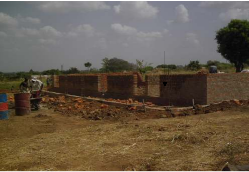
レンガ塀の積み上げ作業
