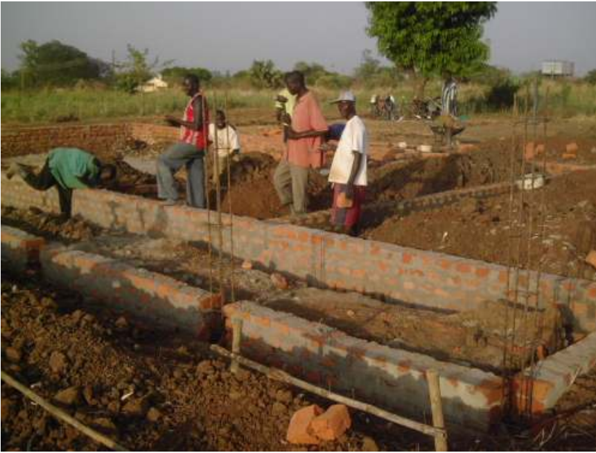
基礎工事の様子
