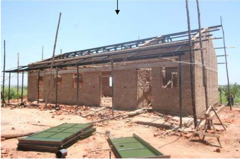
レンガの積み上げ作業が終わり屋根工事開始された時の様子。
