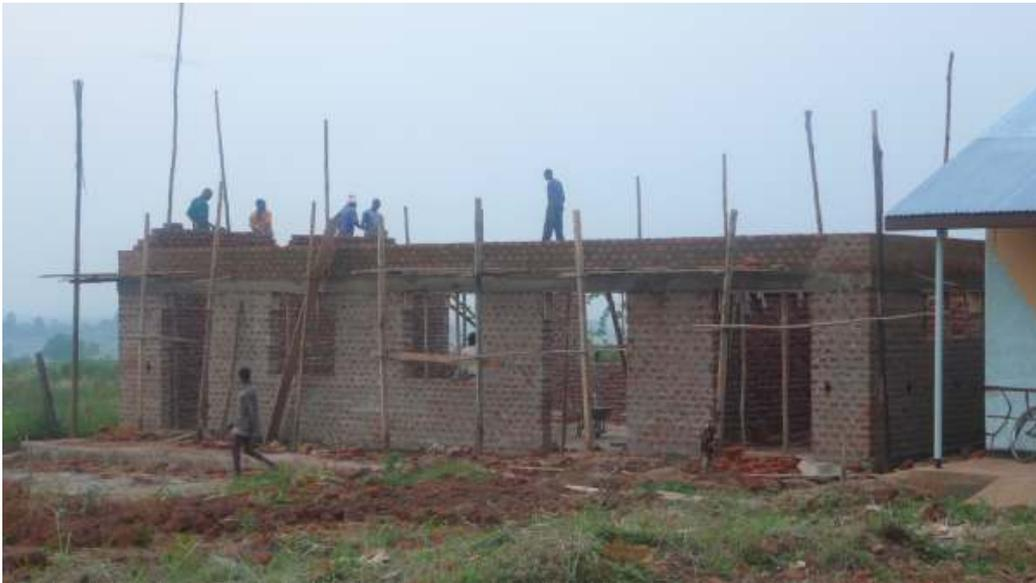
【写真】 壁のレンガ積み上げ作業が終わり屋根工事が始まった様子
