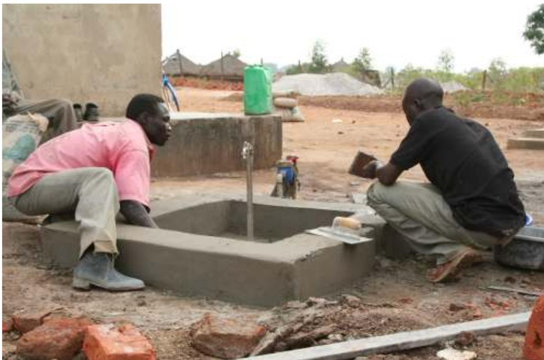
【写真】 水道設置の様子。水道は1キロの離れた水源(水道)から地下にパイプを埋め工事を行いました。パイプの埋設工事に時間がかかりましたが、これまで水道がなく1キロの道のりをポリタンクで水を運んでいたのが、水が出た時は、スタッフ、受益者共に本当に大喜びでした。
