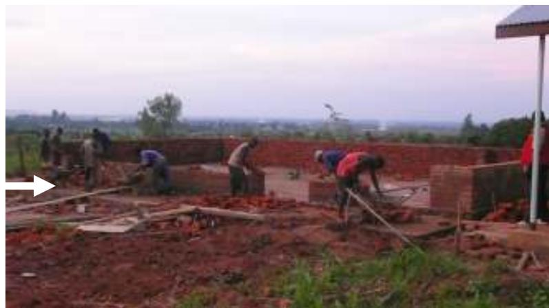
【写真】基礎工事が終わり、レンガで壁を積み上げていく作業
