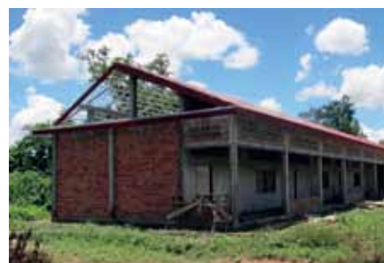
ブオ・ソクリアチ村小学校建設
