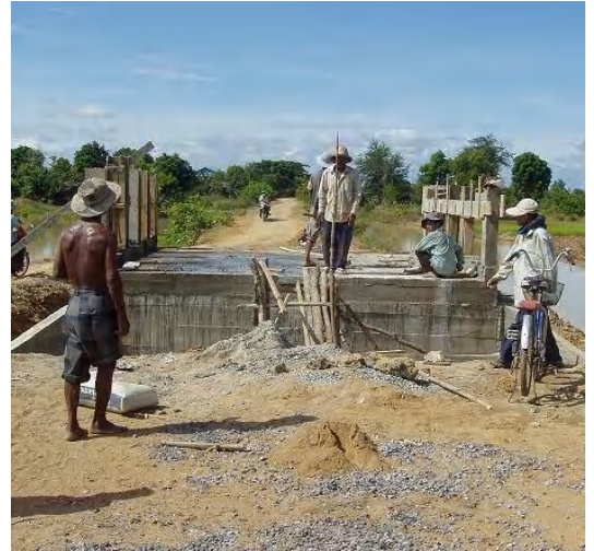
村へつながる道にかかる橋。村人たちが自分たちで労働力を賄い、建設をしている様子
