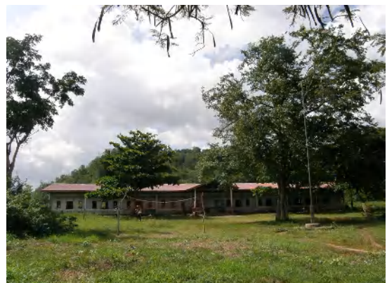
屋根と一部の壁の修理が完了した小学校の校舎
