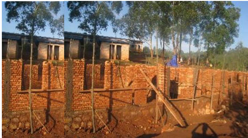
【写真：施設建設の様子】
