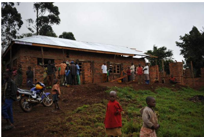
グローブハウスⅢの骨格が完成
