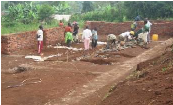
グローブハウスⅢの建設工事が始まったときの様子
