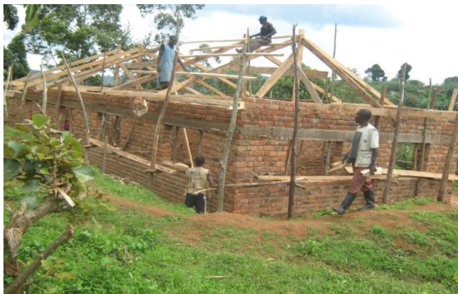
屋根工事が始まった時の様子
