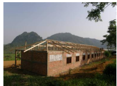
建設中の中学校の様子
