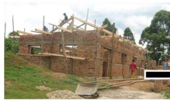
屋根工事の様子
