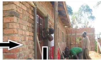
ドア・窓の取り付け作業
