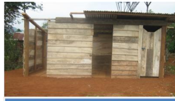
完成したトイレ
