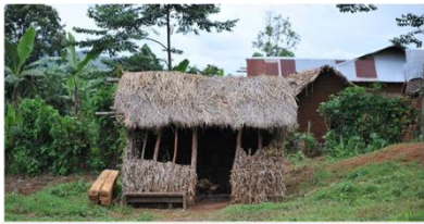
完成した守衛小屋
